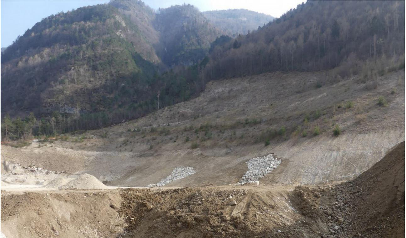
*Figura 9.1 Ripresa fotografica dal piano di cava: gli accumuli di blocchi lungo il versante rimodellato indicano le zone di emergenza idrica - i blocchi fungono da dreno e consentono la periodica emergenza idrica evitando l'erosione del versante*
