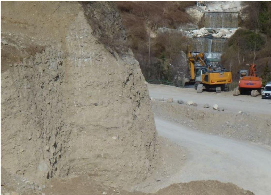
*Figura 8.3 La ripida sezione di scavo evidenzia la coesione dei terreni che risultano quasi cementati*
