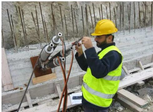
Si tratta di un intervento eseguito su masse rocciose di media-grossa taglia, per renderle stabili e per evitare ulteriori dissesti delle stesse. Tali interventi vengono eseguiti, mediante l'utilizzo di perforatori trivelle, a rotazione o rotopercolazione su rocce o terreni vegetali e a qualsiasi profondità, con successiva iniezione di miscela cementizia, posa tirante, rispettivo posizionamento di piastra con bullone e se richiesto il tesaggio dello stesso tirante a seconda se attivo o passivo.
